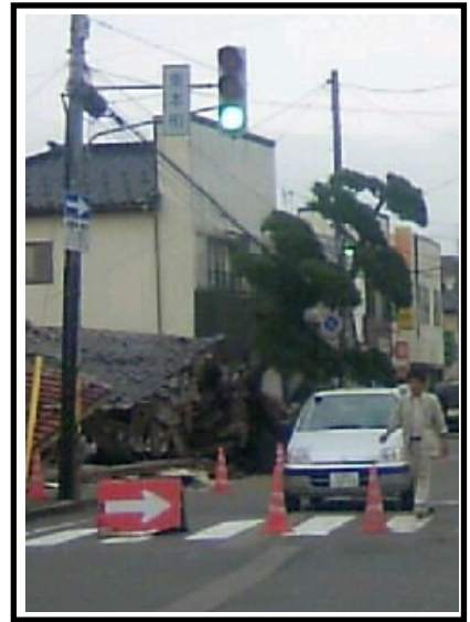
6年前の中越地震。完全に崩落した家
